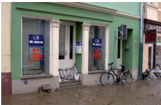
Die alte db-Filiale in Döbeln war schwer vom Hochwasser betroffen.
